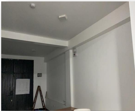
Ventanas y puertas cerradas, pisos en buen estado
