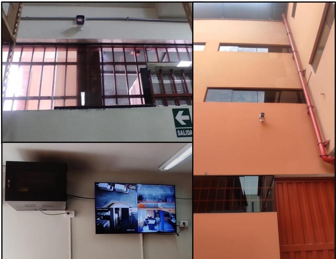
**FOTO N°11: Instalación de cámaras de videovigilancia**
