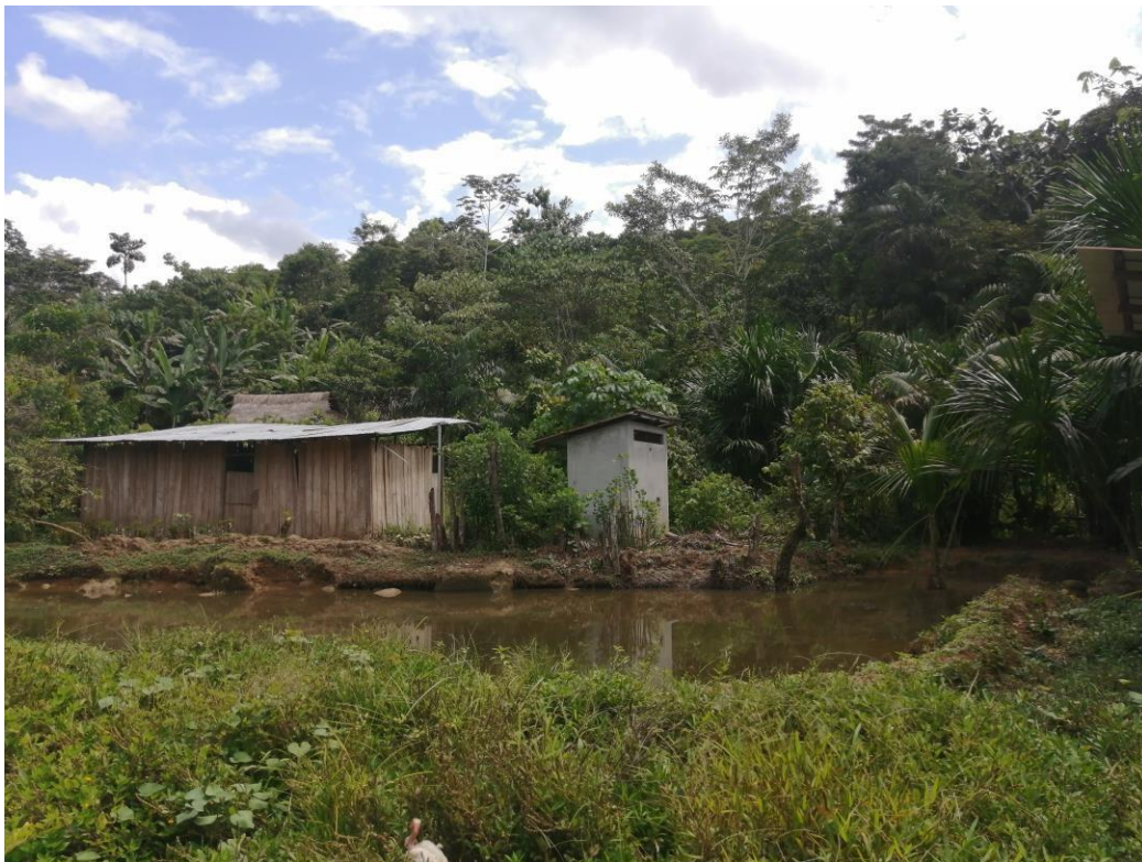
Figura 23: fotografía de una UBS (Unidad Básica de Saneamiento)
