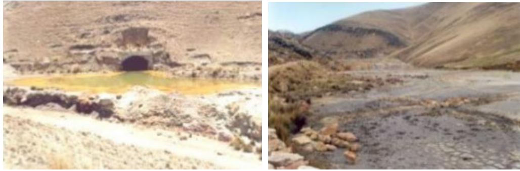
Figura 3. Drenajes ácidos expuestos con aguas superficiales. Fuente: Guerreo, 2012.
