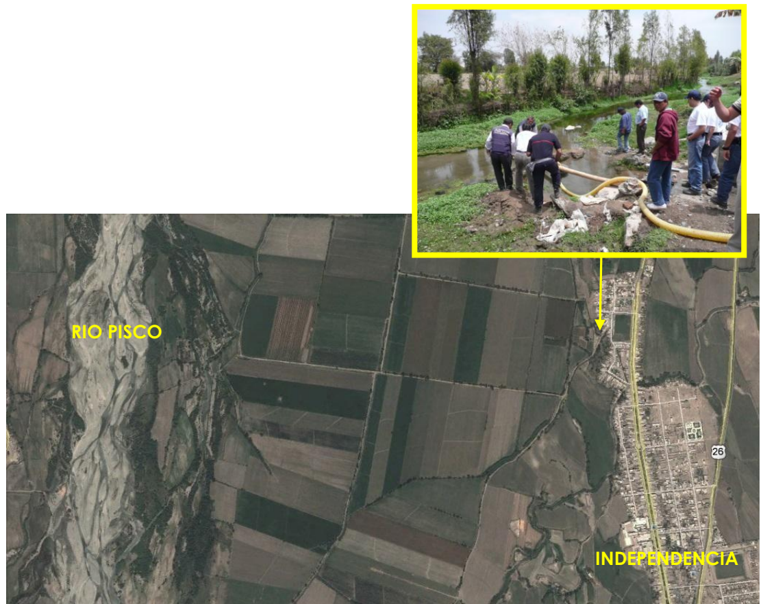
Figura N° 9.- Fuente de agua cruda en punto de captación en distrito de Independencia.
