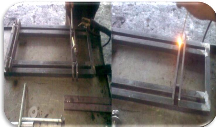
Figura 15 Medición y Soldadura de Soportes de ajuste de la culata
