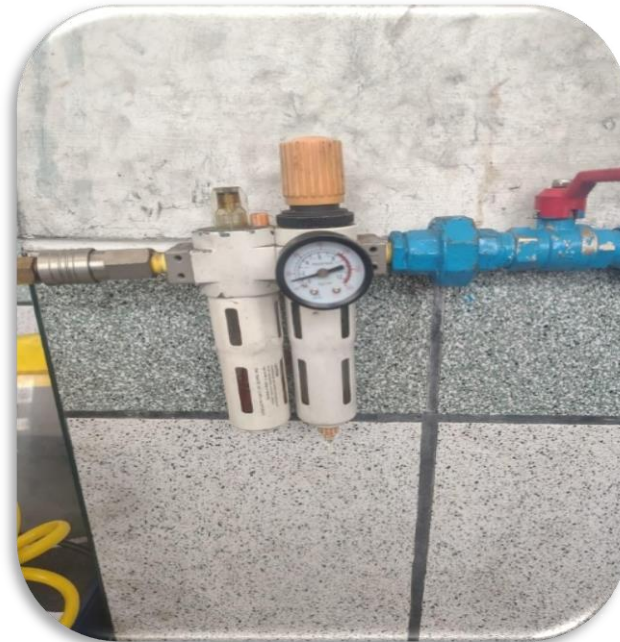
Figura 27. Foto de manómetro de presión de aire
