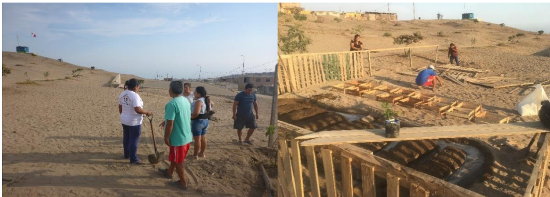
Fotografías 3 y 4. Construcción del cercado y preparación del terreno.
