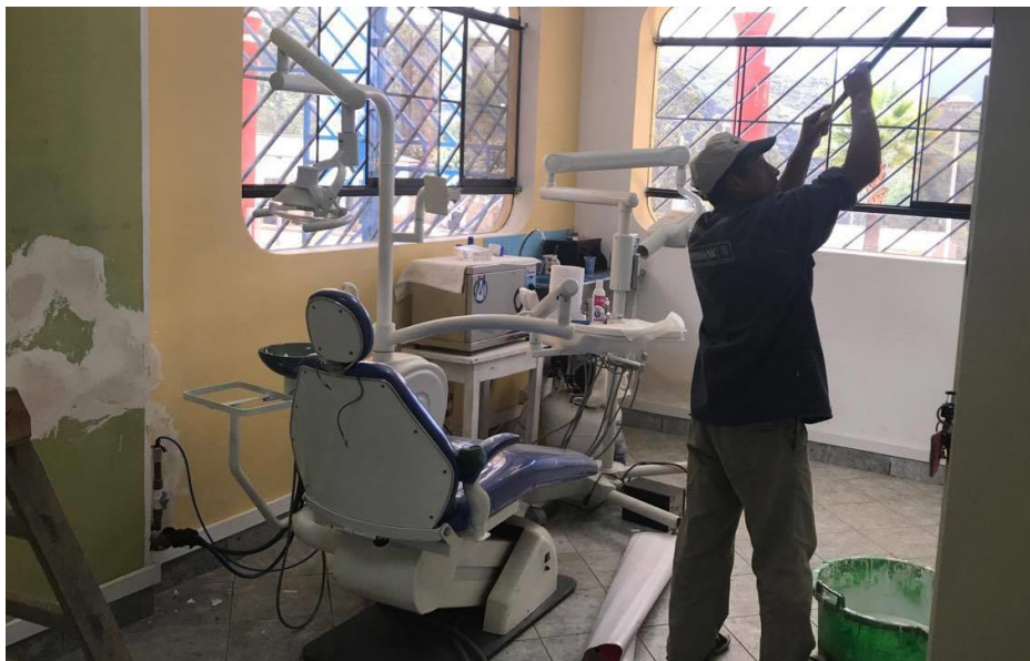
FIGURA. 5 REMODELACIÓN DEL CONSULTORIO DENTAL DEL CONSULTORIO MUNICIPAL.
