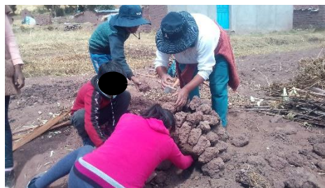
Imagen tomada en la construcción del horno con la ayuda de la madre (Cód. CNIS1. 2019).
