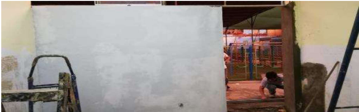
Figure 7: Fotografía del ultimo día de trabajo de los albañiles contratados.
