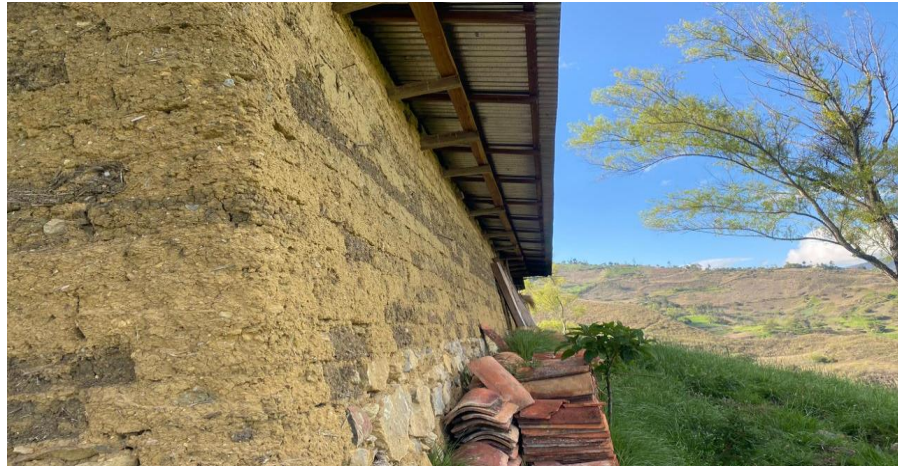
Anexo 6.4. En esta imagen podemos ver las pilas de tejas, alrededor de la vivienda como se encuentran en muchas de las viviendas del Centro Poblado Rural Aullan. Aullan-2023 (Creditos Claudia Arevalo).
