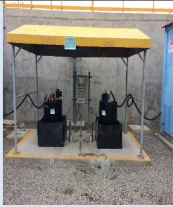
Dosificación de cloro (postcloración)
