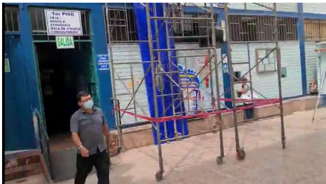
Áreas del Policlínico San José Obrero con Andamios
