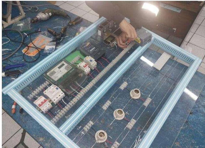
Cableado del módulo didáctico
