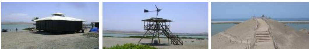
7.2 Izquierda: Estructura típica de bungalós y oficina administrativa, ambos de control municipal. Centro: Torre mirador con aerogenerador. Izquierda: Senderos turísticos sobre las dunas.
